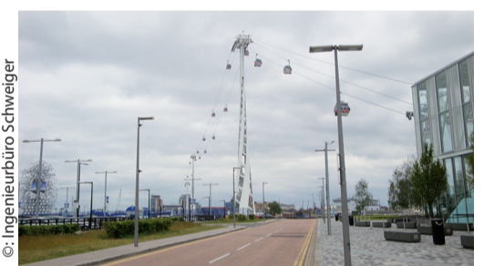
Schlanke, filigrane Stützen im Stadtbild
