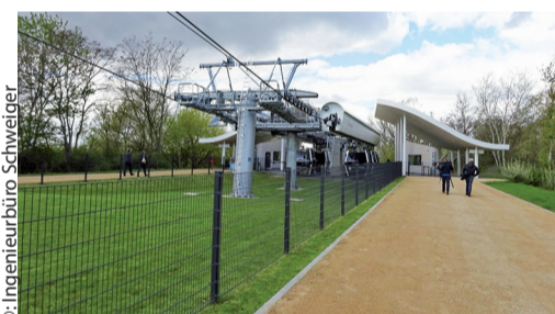
Zwischenstation im IGA-Gelände Berlin
